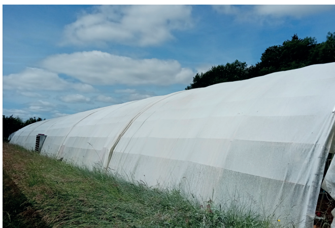
Intervention de blanchiment réalisée par drone
